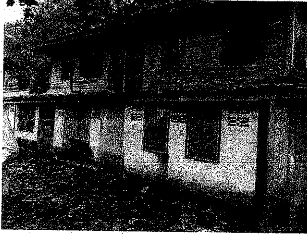
๔. หลังลำดับที่ ๔ บ้านพักพนักงานเรือนจำ - ห้องแถวครึ่งตึกครึ่งไม้ ๒ ชั้น
