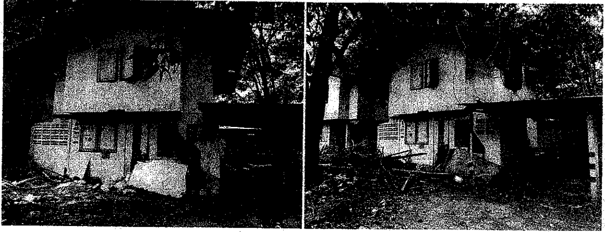
๘. หลังลำดับที่ ๘ บ้านพักพนักงานเรือนจำ - ครึ่งตึกครึ่งไม้ (วิว่าบอร์ด) ๒ ชั้น
