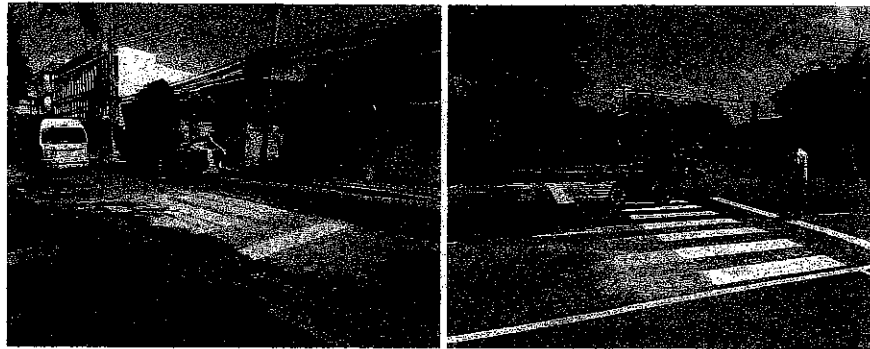
ภาพปัญหาการซ้อนทับของทางข้ามม้าลายเดิม และทางข้ามม้าลายใหม่ บนผิวแอสฟัลต์ติกคอนกรีต
